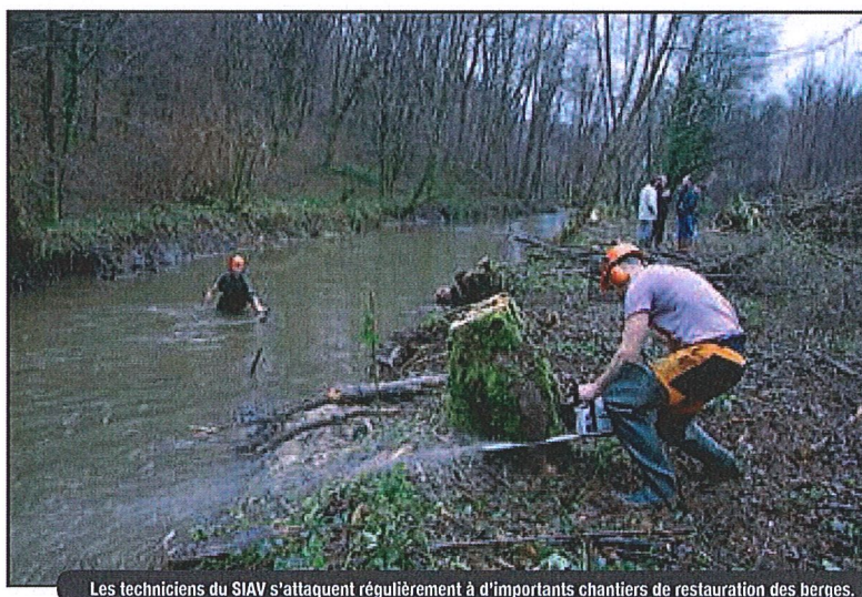
Les techniciens du SIAV s'attaquent régulièrement à d'importants chantiers de restauration des berges.
