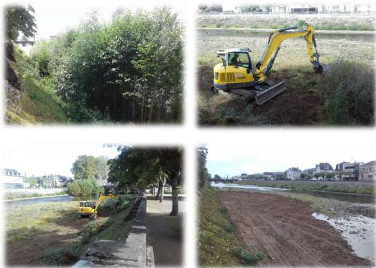
Figure 18 : Photos des travaux de scarification de la Corrèze
