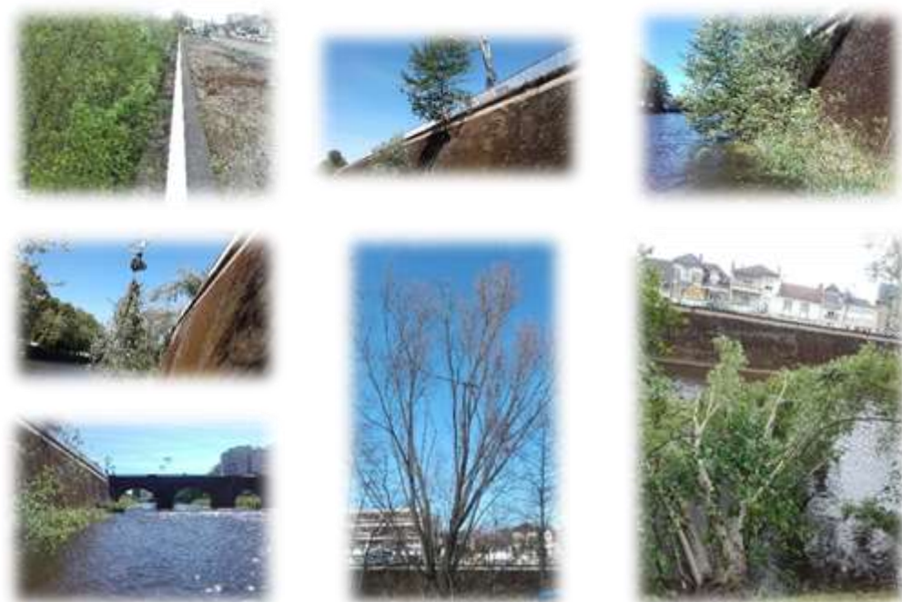
Figure 4 : Photos des évacuations d'arbres sur la Corrèze
