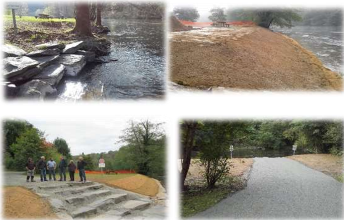
Figure 20 : Photos des travaux d'aménagement : halte nautique d'ESTIVAUX
