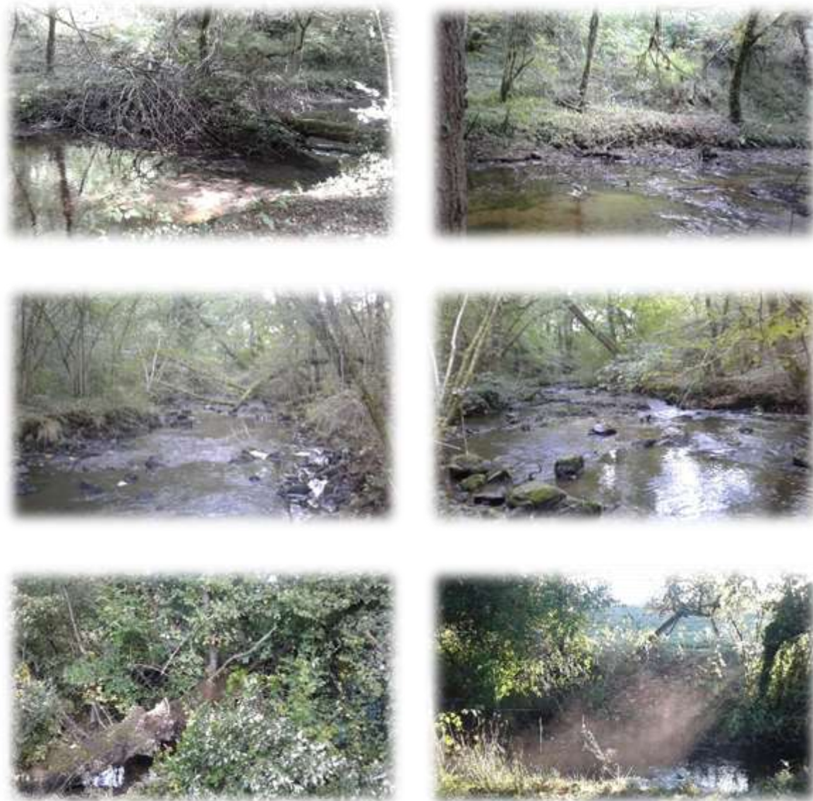
Figure 12 : Photos du traitement de la végétation des berges sur le Ganaveix
