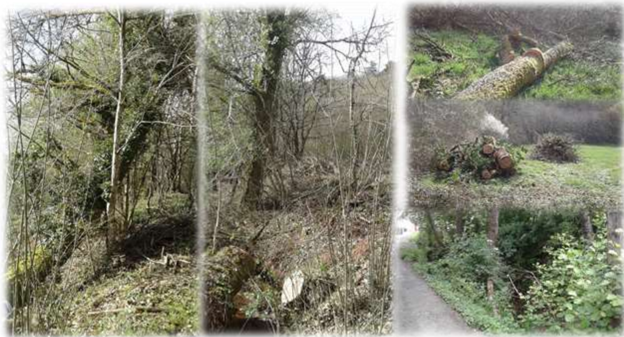
Figure 10 : Photos d'évacuation d'arbres sur le Pian
