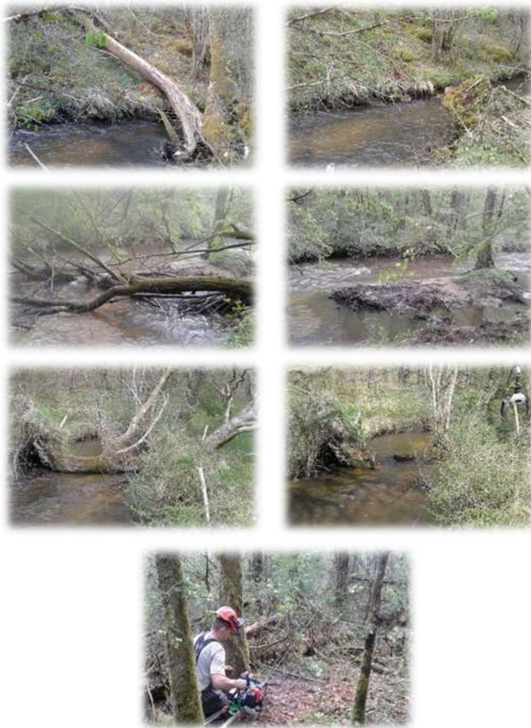
Figure 11 : Photos du traitement de la végétation des berges sur le Bradascou
