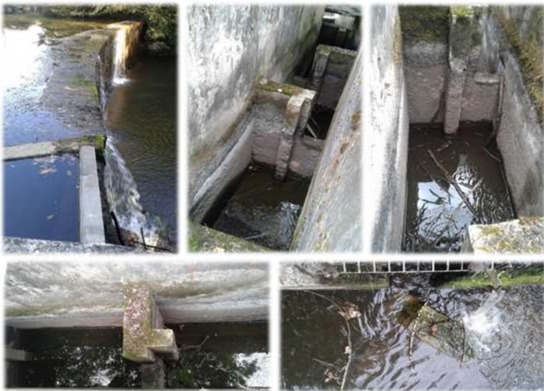
Figure 15 : Photos de la passe à poissons du seuil d'Objat
