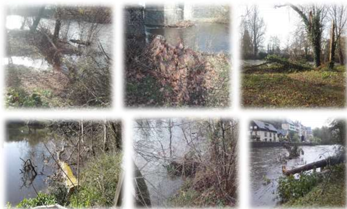
Figure 6 : Quelques photos de l'évacuation d'arbres sur la Corrèze et la Vézère
