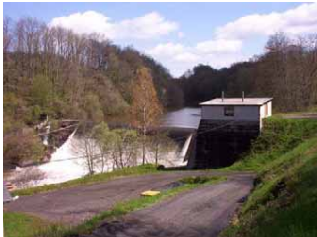
Photo 5 : Barrage du Gour Noir
