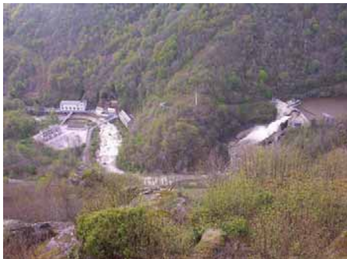
Photo 4 : Barrage et centrale hydroélectrique du Saillant
