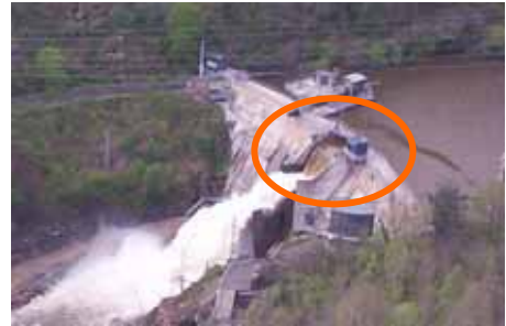
Photo 3 : Crête de déversement, barrage du Saillant
