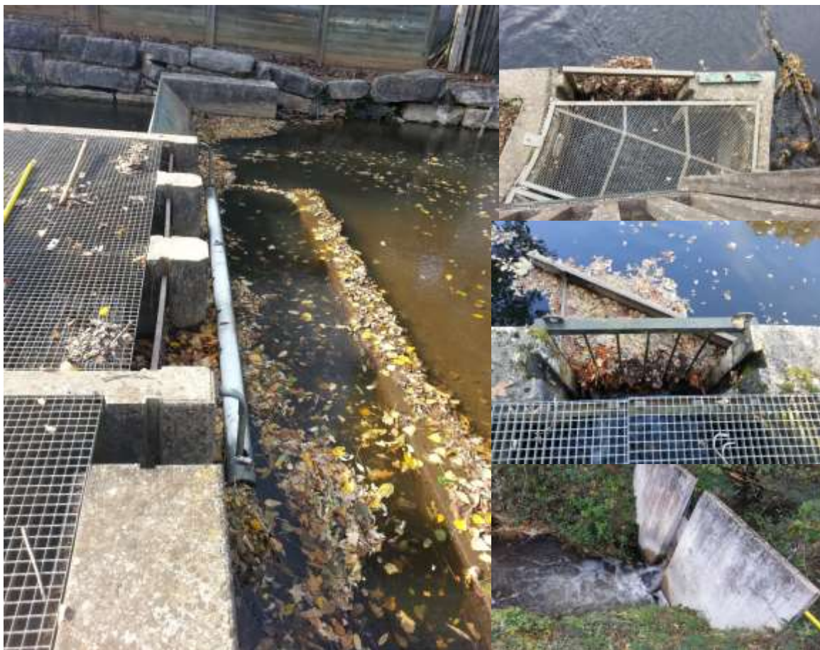
Figure 2 : Amont des passes à poissons suivis par le SIAV
