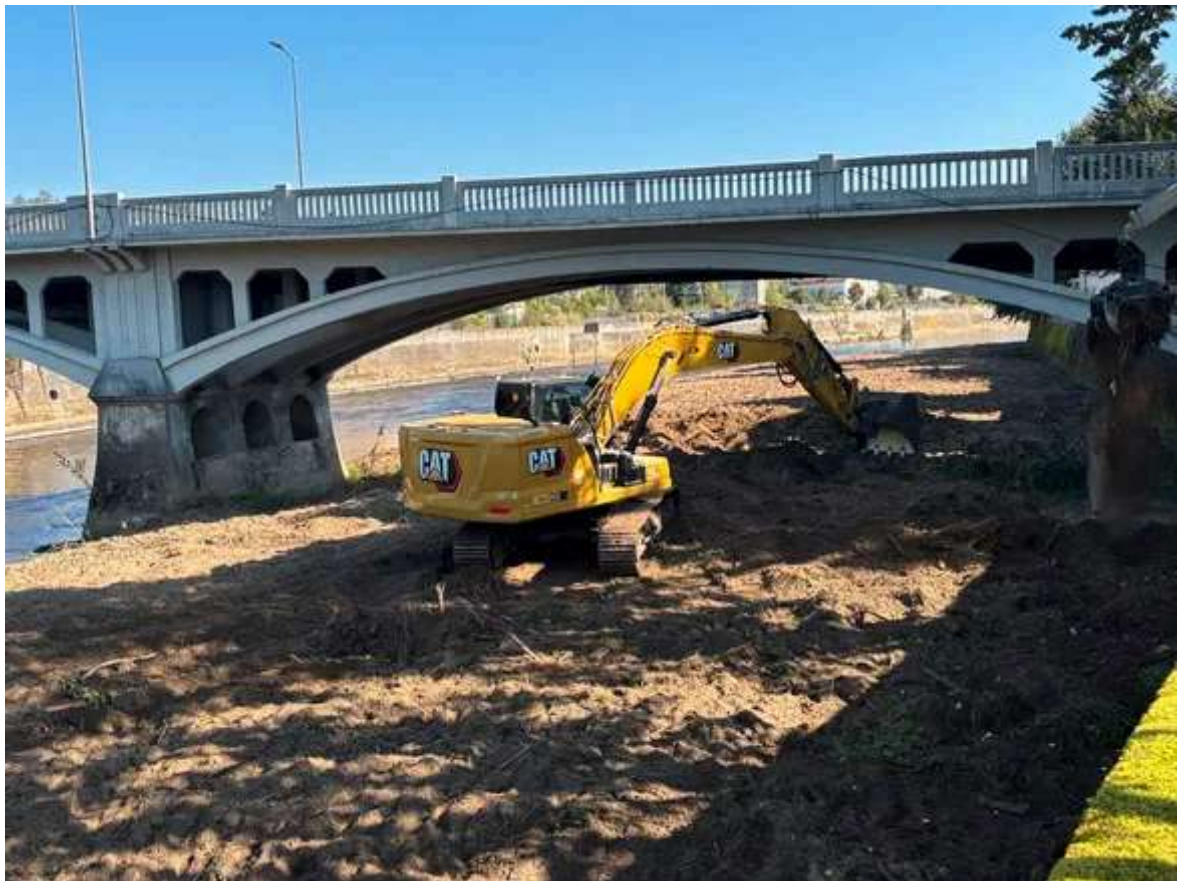
La pelleteuse a retiré toute la végétation qui s'était installée de part et d'autre du pont. © Agence Brive
