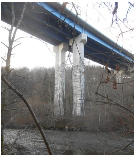
Pont autoroutier de l'A20 entre Uzerche et Vigeois (2017)
