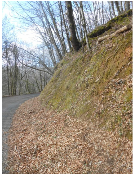
Talus de bord de route, face à Comborn (Estivaux)
