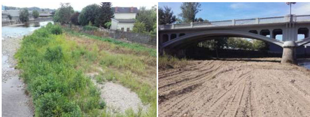
Figure 3 : Atterrissement du pont de la Bouvie avant et après travaux 2016
