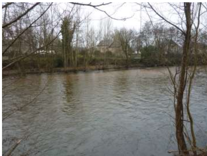
Figure 1 : Atterrissement rue du bac début 2016 noyée par un niveau moyen de la Corrèze.
