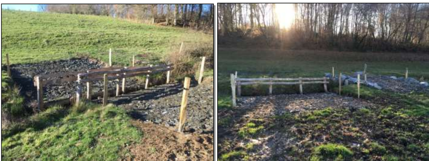
Figure 8 : Photos de descentes aménagées
