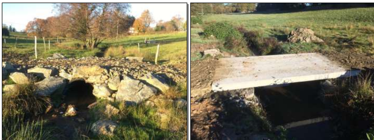
Figure 7 : Photos d'un passage busé et d'une passerelle béton
